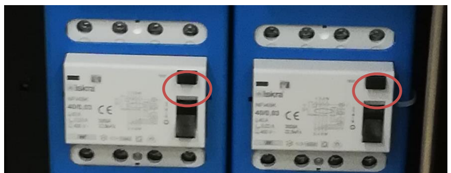
Figur 43: Testknapp för RCD
