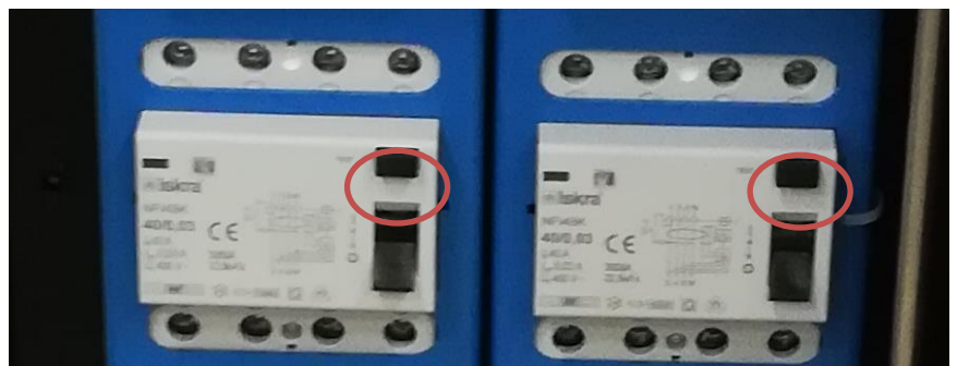
Slika 43: Gumb za testiranje FID stikala (RCD)
