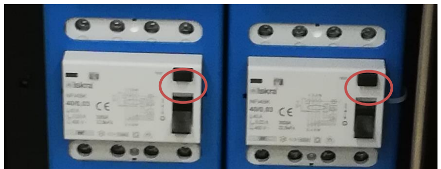
Figura 43: Botões de teste RCD
