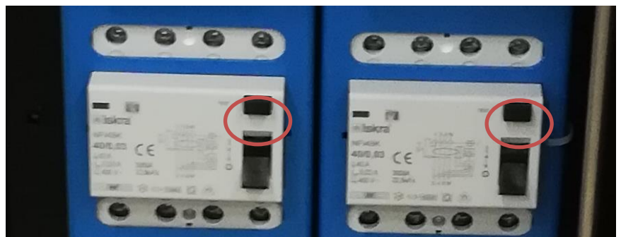
Afbeelding 43: RCD-testknoppen
