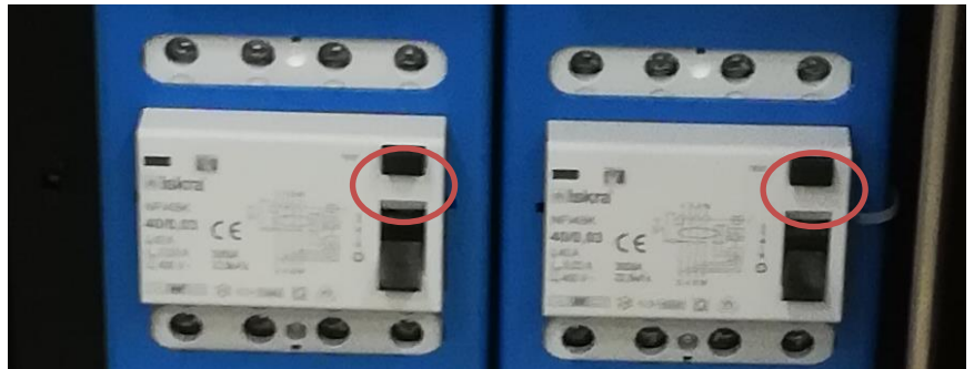
Slika 43: Gumbi za testiranje RCD sklopke
