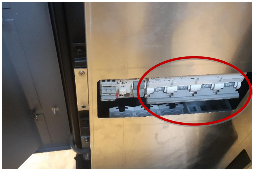
Kuva 44: Latausasema voidaan nollata pääkatkaisijaa käyttämällä
