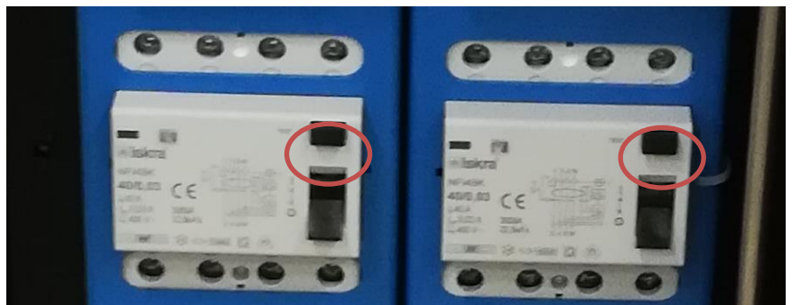
Kuva 43: Vikavirtasuojakytkimien testipainikkeet
