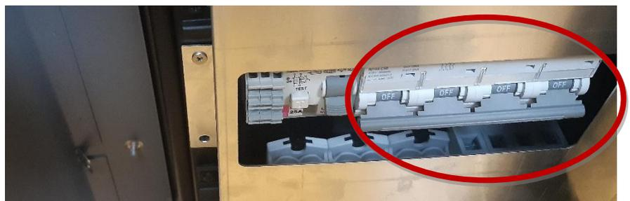
Abbildung 44: Der Haupt-Leistungsschalter kann zum Zurücksetzen der Ladestation verwendet werden
