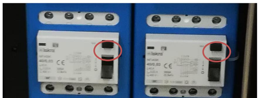
Abbildung 43: Fehlerstromschutzschalter-Testtasten
