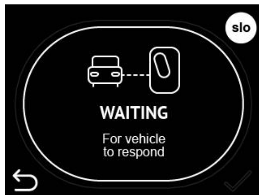
Figur 16: Laddningsstationen väntar på att fordonet ska svara och börjar ladda
