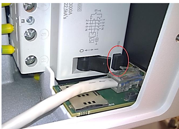
Obrázok 34: Testovacie tlačidlo prúdového chrániča (RCD)
