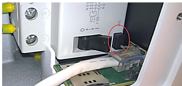
Slika 42: Gumb za testiranje FID stikala (RCD)
