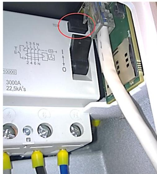
Figura 10: Pulsante del test RCD
